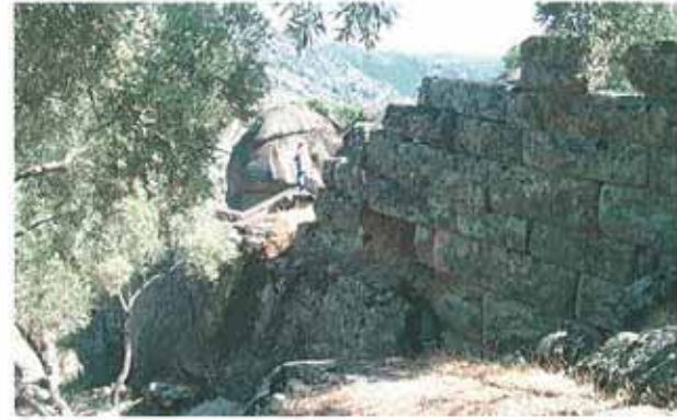
Res. 69. Çine, Hacıpaşalar Asartepe (env. no: N20A002) yerleşimindeki sur duvarı.
