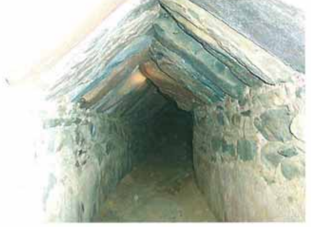
Res. 4. Talleis su sisteminin Taşkemer-Kızlarkulesi arasındaki bölümünde yer alan üçgen tepeli galeri.
