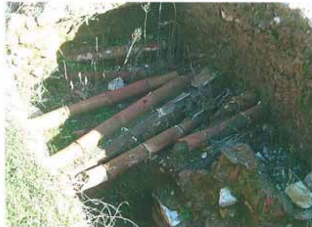
Res. 2. Tralleis'teki Roma Devri hamamının su boruları.
