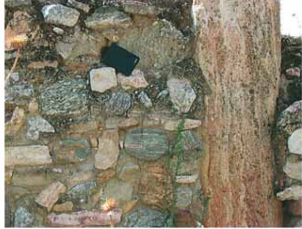
Res. 8. Tripolis stoasında traverten sütün ve duvar yapımında kullanılmış gnays, metamorfik şist, mermer, traverten türü kayalar (gözl. no: L21JJ002).
